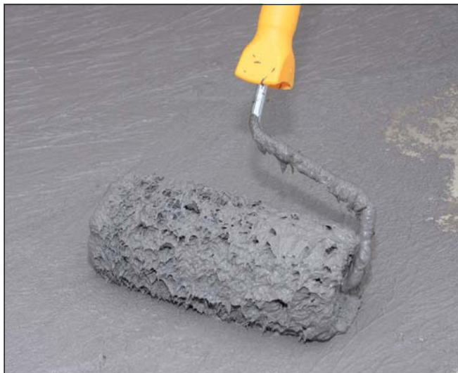
13 Masę uszczelniającą Sopro TDS 823 można nakładać również przy pomocy wałka futrzanego.
