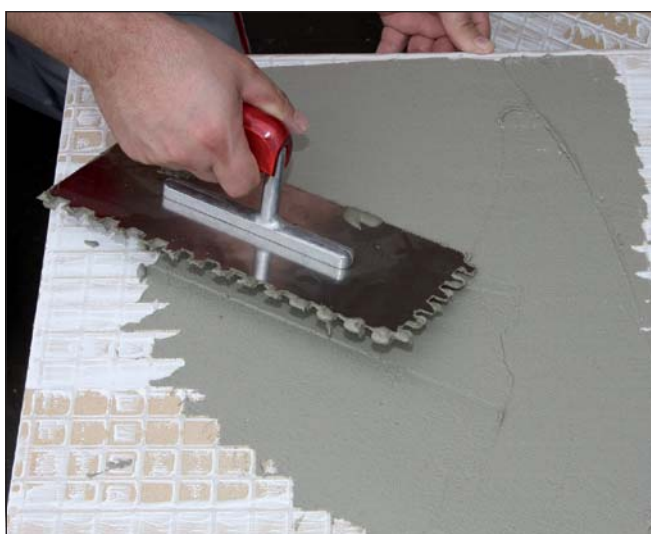
17 Zastosowanie metody kombinowanej przy klejeniu okładziny zależy od formatu i właściwości spodniej części płytki i służy układaniu z pełnym przyleganiem okładziny do podłoża.
