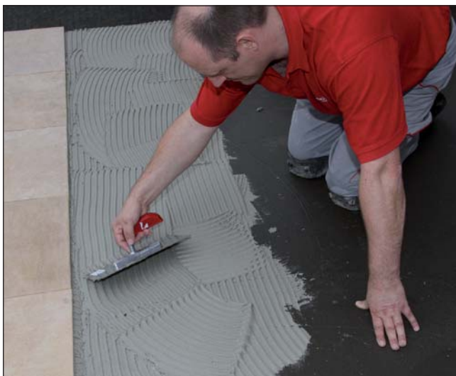
16 Na utwardzone uszczelnienie nałożyć wysokoelastyczną dwuskładnikową zaprawę klejową S2 Sopro megaFlex S2 lub wysokoelastyczną dwuskładnikową zaprawę klejową szybkowiązącą S2 Sopro megaFlex S2 turbo .
